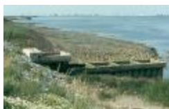
Verlaatsluis in Doel (PCPP20110912016)
