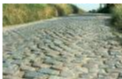
Bestrating van de Fortstraat (PCPP20110919001)
