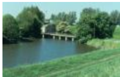
Gracht en toegangsbrug van het fort Liefkenshoek (PCPP20110926008)
