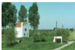
Bunker in de Fortstraat, Doel (PCPP20110912015)
