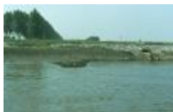
Frans dijkje en verlaatsluis (PCPP20110919003)
