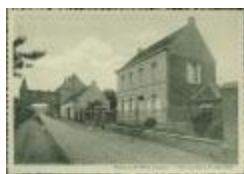
Cauwenstraat - Vrasene (Vrasene_PK_001_CAUWENSTRAAT)
