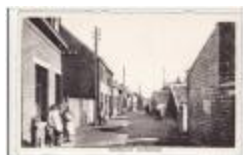
Grensstraat, Kieldrecht (Kieldrecht_PK_005_GRENSSTR)
