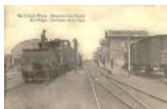
Spoorlijn 54, station De Klinge (SASN20110222_008)
