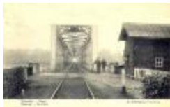
Spoorlijn 54 Mechelen - Terneuzen, Scheldebrug (SASN20110222_012)
