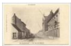
Dorpstraat - Kieldrecht (Kieldrecht_PK_003_DORPSTR)
