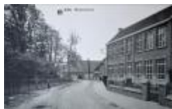
Meisjesschool - Kallo (Kallo_PK_005_MEISJESSCHOOL)
