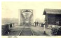
Spoorlijn 54 Mechelen - Terneuzen, Scheldebrug (SASN20110222_012)
