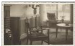
Interieur van een woning (WAS001000093)
