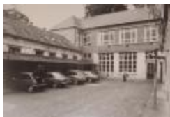
Beveren, Kloosterstraat, Gemeentelijk technisch instituut (GTI) (BBE001000012)
