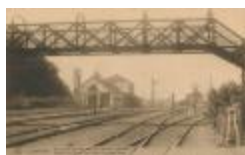
Prentkaart Spoorlijn 59 station Lokeren, voetgangersbrug. (PCMC20120423_010)
