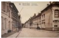
Vrasenestraat, Beveren (Beveren_PK_007_VRASENESTRAAT)
