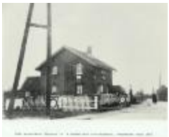
Spoorweg Shondstraat, Station Sint-Pauwels (HKDKSP20110214-06)
