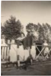
Spoorweg Shondstraat, Station Sint-Pauwels (HKDKSP20110214-03)
