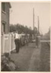
Spoorweg Shondstraat, Station Sint-Pauwels (HKDKSP20110214-04)
