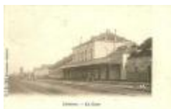
Station Lokeren, eerste stationsgebouw achterzijde (SASN20110222_037)
