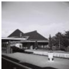
Spoorlijn 59 Station Lokeren (PCMC20120417_001)
