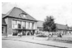
Station Lokeren, huidige stationsgebouw, jaren 1950 (SASN20110222_038)
