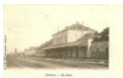
Station Lokeren, eerste stationsgebouw achterzijde (SASN20110222_037)
