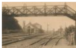
Prentkaart Spoorlijn 59 station Lokeren, voetgangersbrug. (PCMC20120423_010)
