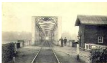
Spoorlijn 54 Mechelen - Terneuzen, Scheldebrug (SASN20110222_012)
