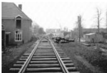
Spoorlijn 54 Mechelen - Terneuzen, spoor en Scheldebrug Temse (SASN20110222_051)
