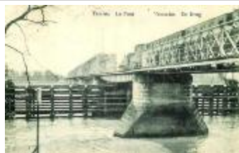
Spoorlijn 54 Mechelen - Terneuzen, spoor en Scheldebrug Temse (SASN20110222_014)
