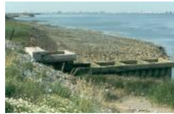
Verlaatsluis in Doel (PCPP20110912016)
