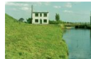
Huis aan de Witte Brug in Doel (PCPP20110912005)
