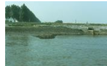
Frans dijkje en verlaatsluis (PCPP20110919003)
