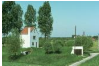
Bunker in de Fortstraat, Doel (PCPP20110912015)
