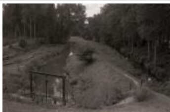
Heirbeek sluis 1990-2012 (Heirbeek sluis west voor)
