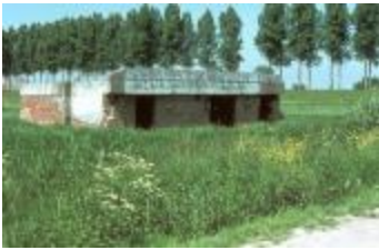
Bunker in de Fortstraat, Doel (PCPP20110912014)
