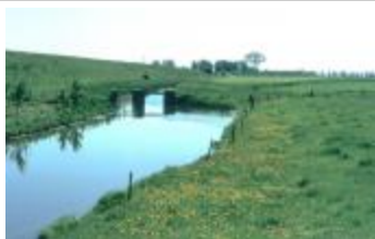
Watergang onder de scheldedijk (PCPP20110912006)
