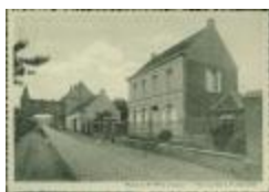
Cauwenstraat - Vrasene (Vrasene_PK_001_CAUWENSTRAAT)
