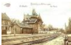
Spoorlijn 54 Mechelen - Terneuzen, station Bornem (SASN20110222_009)
