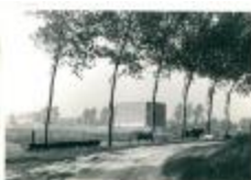
Transformatiepost (Ebes) Kapeldijk (PCM20120311_008)
