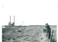
Thermische centrale EBES (PCM20120331_013)
