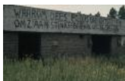
Bunker in de Fortstraat, Doel (PCJM20120902_005)
