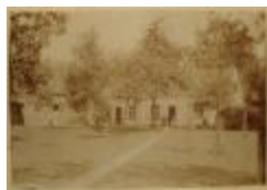
Oude hoeve met boomgaard en losstaande schuur (BBE001000054)
