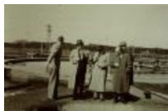
Bedrijfsbezoek aan waterzuiveringsstation (PCWVB20110415_015)
