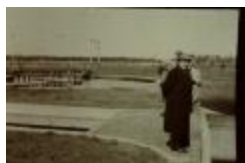
Bedrijfsbezoek aan waterzuiveringsstation (PCWVB20110415_017)
