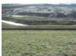
Graafwerken in de polder (p80winter3_0592)
