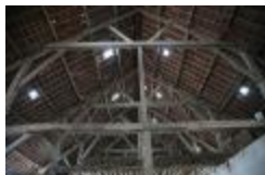
Gebinte van de monumentale schuur van de Antoniushoeve (IMG_0758)
