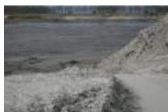
Opgespoten zand (IMG_9608)
