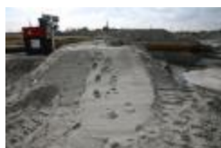
Opgespoten zand (IMG_9610)
