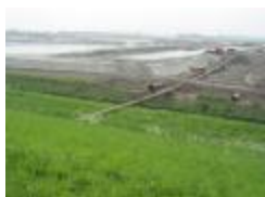
Graafwerken bij de ontpoldering en havenuitbreiding (IMG_0818)
