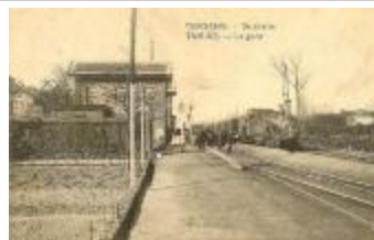
Spoorlijn 54 Mechelen - Terneuzen, oud station Temse (SASN20110222_015)
