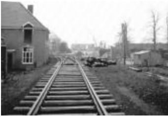
Spoorlijn 54 Mechelen - Terneuzen, spoor en Scheldebrug Temse (SASN20110222_051)
