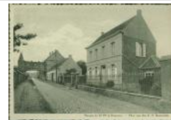
Cauwenstraat - Vrasene (Vrasene_PK_001_CAUWENSTRAAT)
