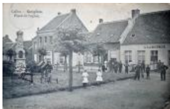
Kerkplein, Kallo (Kallo_PK_003 KERKPLEIN)
