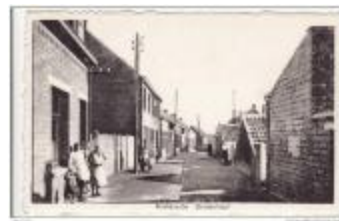
Grensstraat, Kieldrecht (Kieldrecht_PK_005_GRENSSTR)
