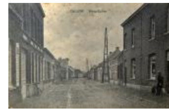
Hoog Kallo, Kallo (Kallo_PK_002_HOOGKALLO)
