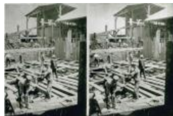
Verplaatsing Dam Statie 8 (GZ Tul213)
