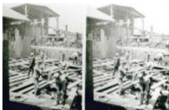
Verplaatsing Dam Statie 9 (GZ Tul215)
