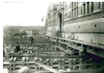
Verplaatsing Dam Statie 3 (GZ Tul208)
