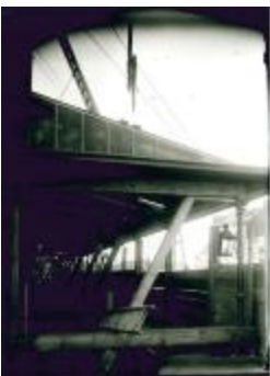
Verplaatsing Dam Statie (GZ Tul206)
