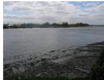
Scheepswerf Maes: constructie waarmee schepen in en uit het water weden gehaald (GZonroerend001)
