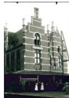
Verplaatsing Dam Statie 5 (GZ Tul210)
