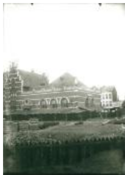
Verplaatsing Dam Statie 2 (GZ Tul207)
