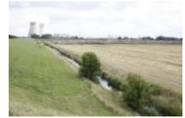
Polderzicht met koeltorens (_MG_0022)
