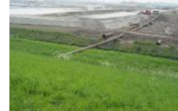
Graafwerken bij de ontpoldering en havenuitbreiding (IMG_0818)
