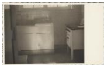
Interieur van een woning (WAS001000095)
