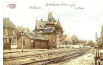
Spoorlijn 54 Mechelen - Terneuzen, station Bornem (SASN20110222_009)
