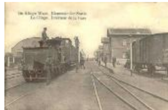
Spoorlijn 54, station De Klinge (SASN20110222_008)
