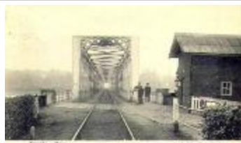
Spoorlijn 54 Mechelen - Terneuzen, Scheldebrug (SASN20110222_012)
